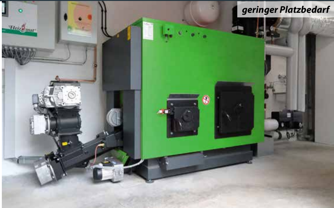
vollautomatische Brennraumentaschung
